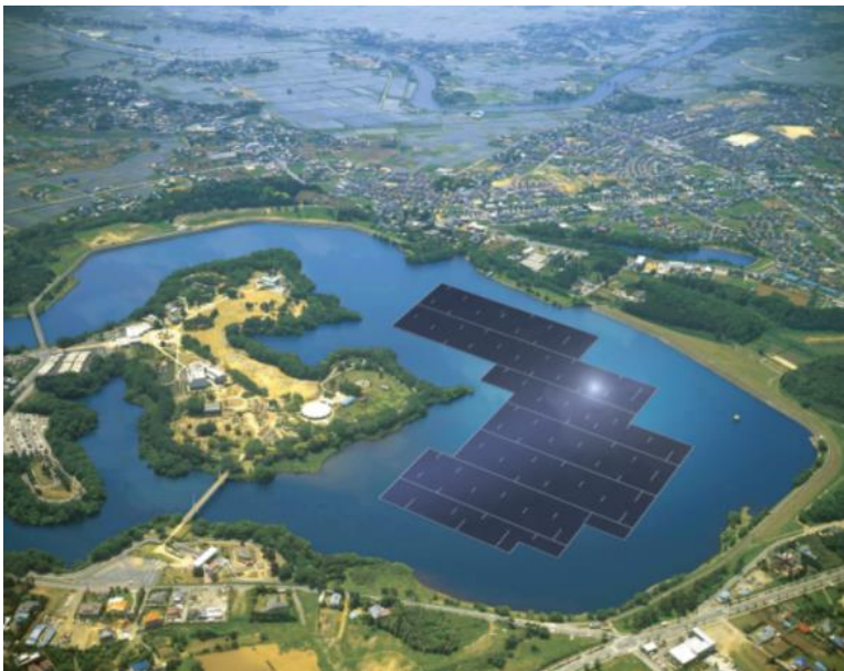
Aperçu de la centrale de 13,7 MW du barrage de Yamakura
